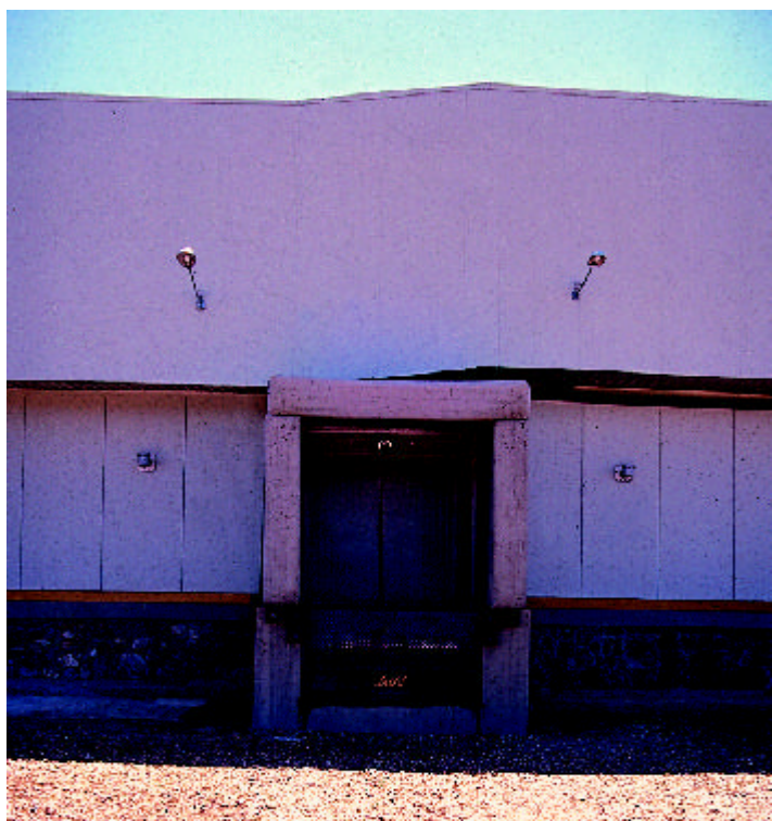
Figura 40. Porta de saída do ambiente refrigerado para o contêiner.
